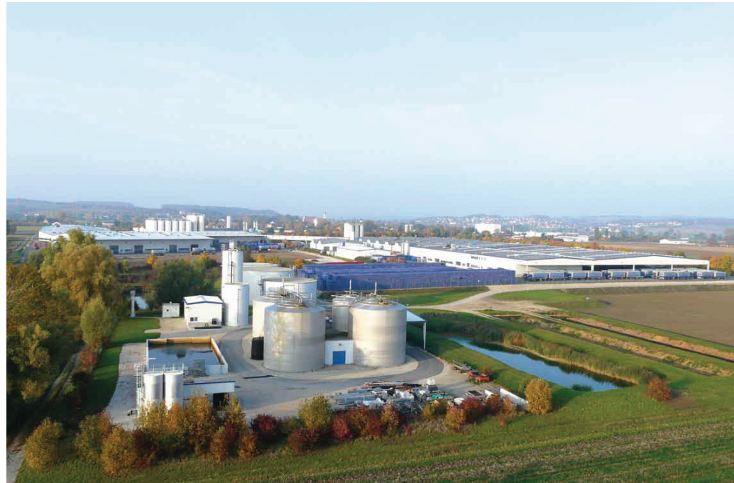
Abb 2: Betriebskläranlage Brauerei Oettingen
