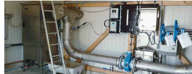
Abb 4b: Einbausituation S:CAN-Sonde zur Ablaufüberwachung
